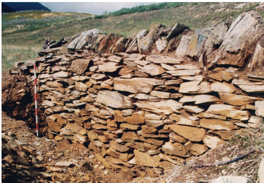
Detalle do muro do depósito da mina da Toca
